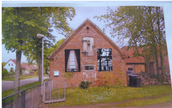
So, wie auf dieser Installation, soll es künftig am Pfarrstall aussehen.
